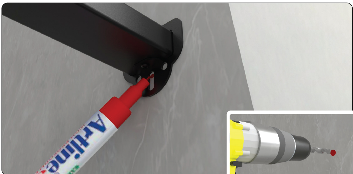
6. มาร์คจุดเจาะผนังและเจาะรูผนังด้วยสว่าน เพื่อติดตั้งระเบียง
